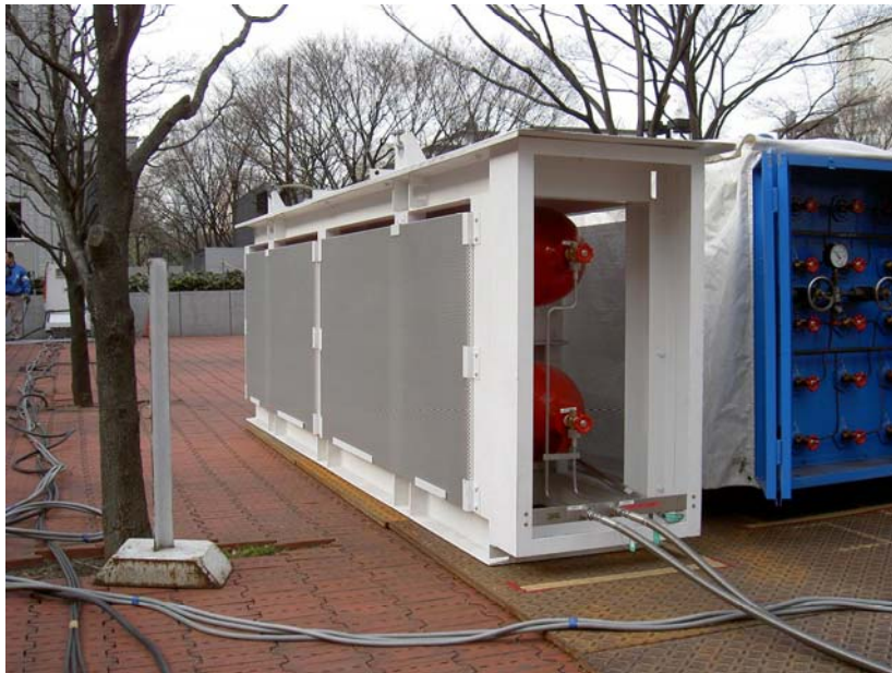
霞ヶ関：蓄ガス設備
